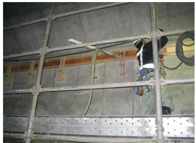
写真－３ 無収縮モルタル充填状況(事例 1)
