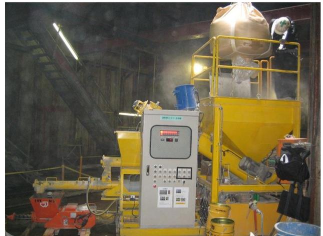
写真－２ 連続練りシステム稼働状況(事例 1)
